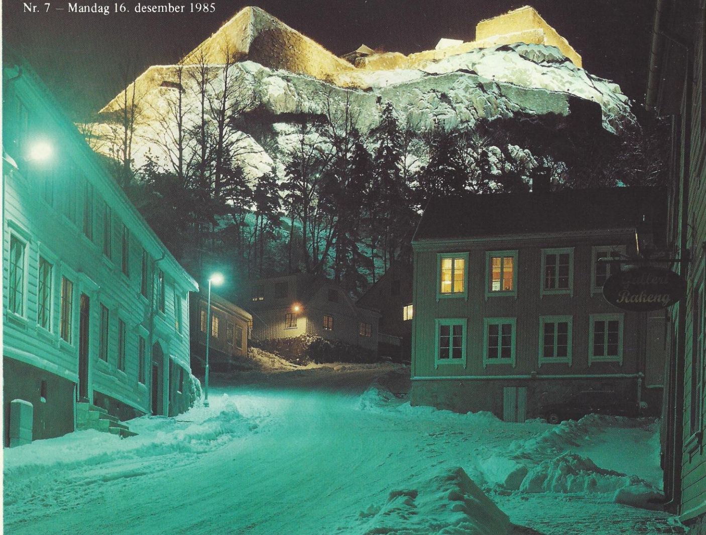
Fredriksten festning i Halden med et av landets mest virkningsfulle flomlysanlegg, montert av Siemens.
